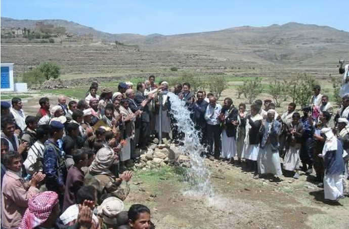
開発調査で供与した揚水ポンプから勢い良く水が吹き出す
